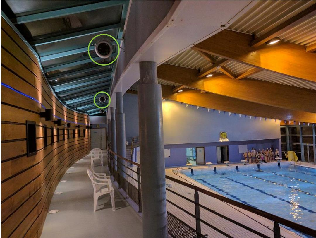
Nuestros dispositivos permiten la circulación del aire para eliminar la condensación.
