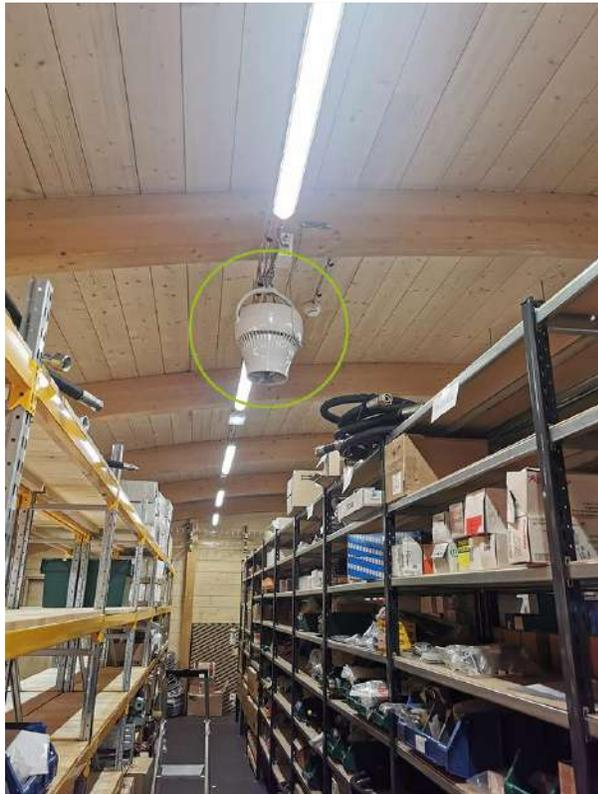
*Puesta en servicio de los desestratificadores Airius : frío récord para esta estación situada en una capa de hielo de 3.300 metros de espesor.*
