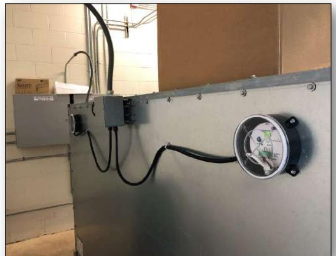
Le purificateur d'air NPBI-G8 est conçu pour un montage sur des gaines intérieures ou extérieures et traite jusqu'à 8.200 m<sup>3</sup>/h
